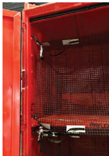
Bilde 15: Nærbilde Øvre Nett Før Oppstramming
