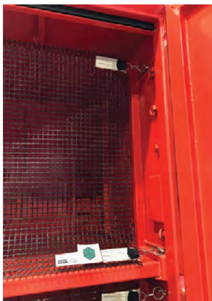
Bilde 19: Nærbilde av Nett Oppstrammet Høyre Side
