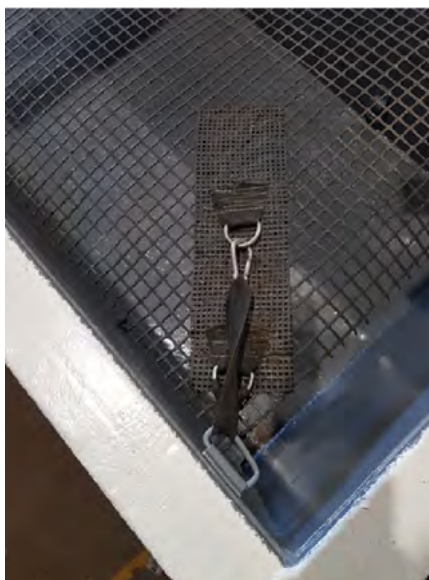
Bilde 14: Montert nett i ett hjørne
